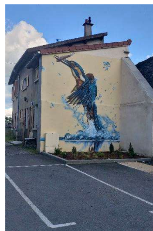
Figure 14 : Démolition pour la création de stationnement et réalisation d'une fresque, commune de Costaros, GAL du Velay, 2021
