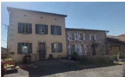
Figure 13 : Réhabilitation de l'ancienne cure, commune de Vernassal, GAL du Velay, 2021
