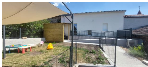
Rénovation thermique de la MAM – Cne du Monteil
